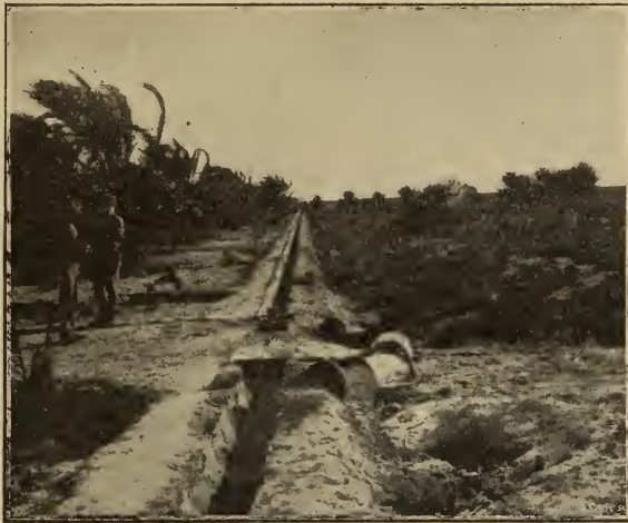
Cliché de l'auteur, janvier 1900.
